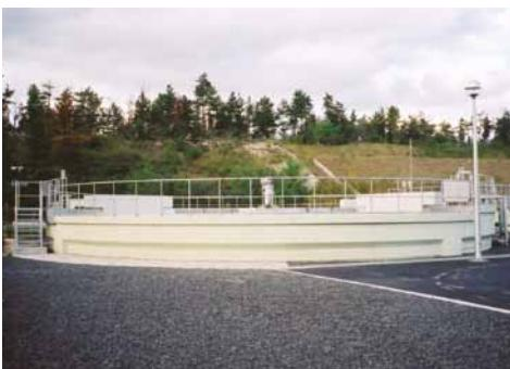
ポストテンション方式フレキャスト下水処理槽
